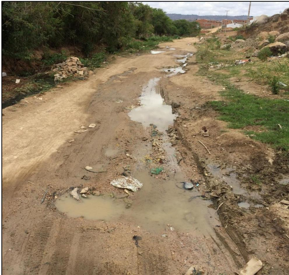
Figura 14: Falta de encanação de águas pluviais. Poças de água.
