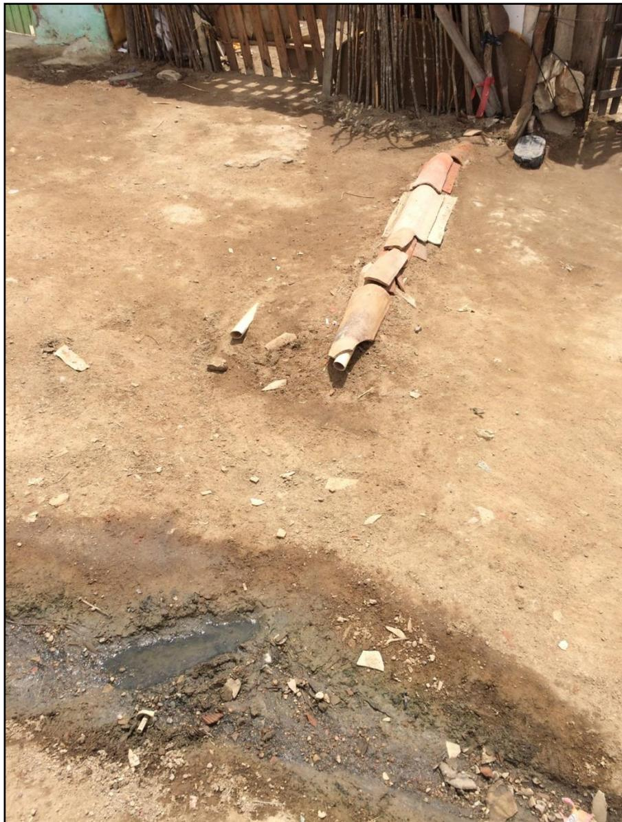
Figura 12: Encanação de esgoto doméstico sendo direcionado para a rua.
