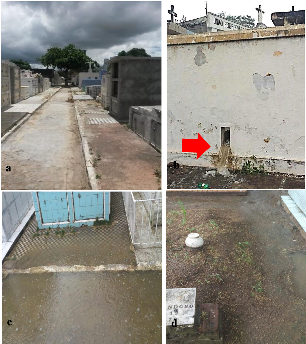
Figura 26. Sistema de escoamento de águas pluviais. a) Via sem estrutura de escoamento. b) Saída da água da chuva pelo muro, direto na calçada. c) Água acumulada junto a estrutura tumular. d) Água acumulada junto a cova rasa
