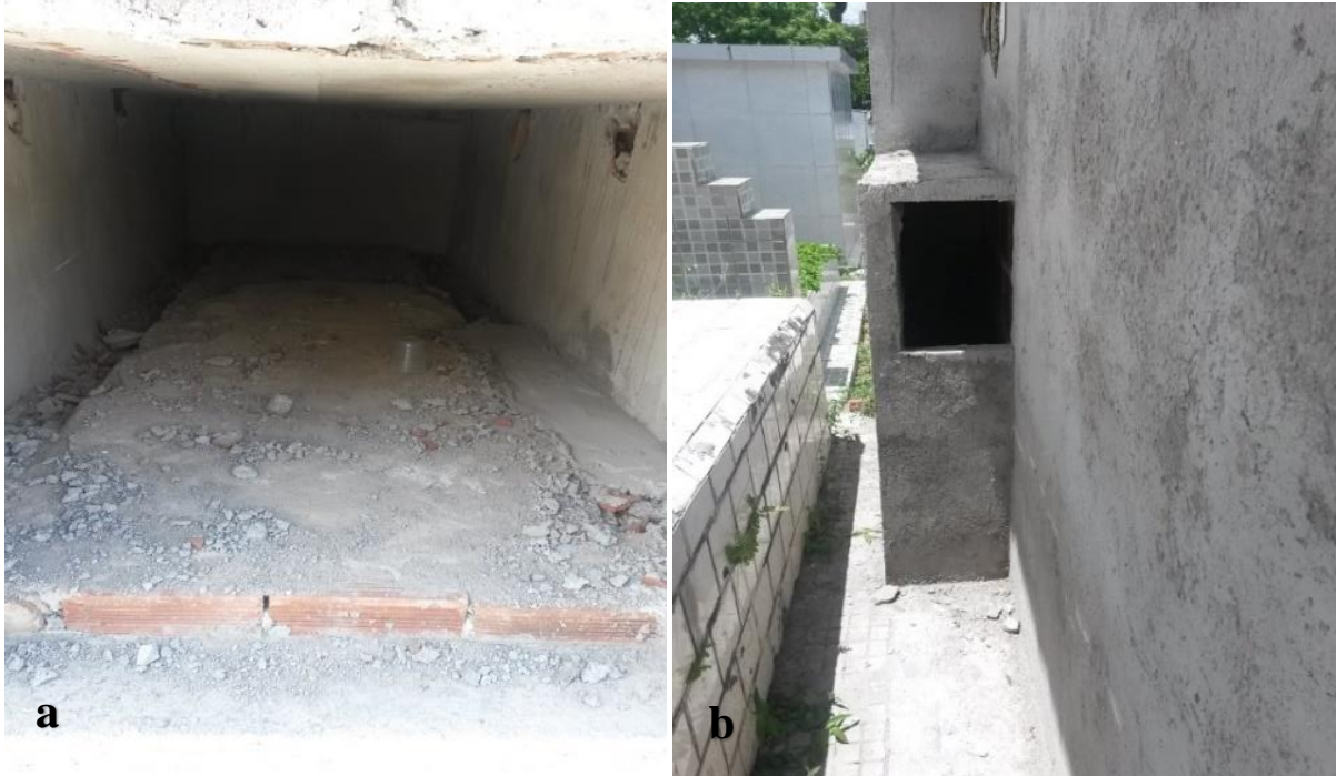
Figura 18. Túmulo com gaveta. a) Gaveta em construção seguindo padrão da legislação. b) Ossuário agregado a estrutura tumular em construção
