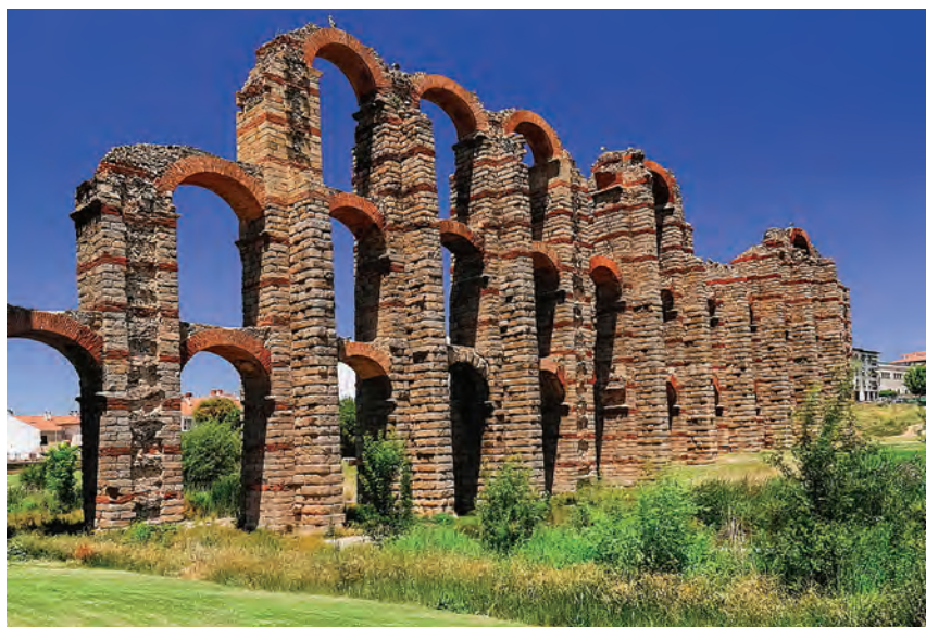
Fig. 7 – O monumental aqueduto dito de Los Milagros, em Emerita Augusta .
