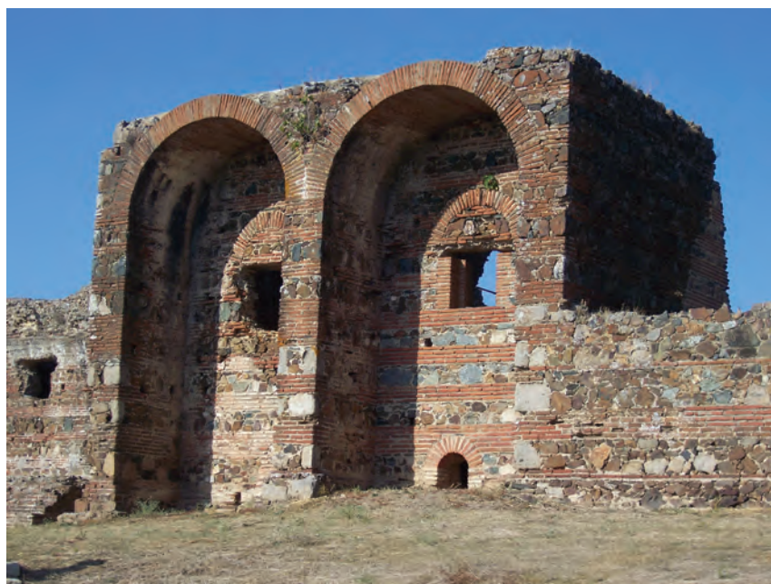
Fig. 2 - Villa romana de S. Cucufate (Vidigueira) - créditos do autor
