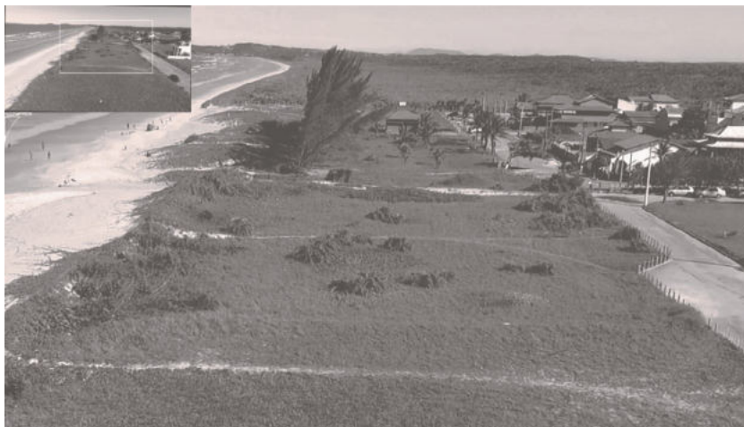
Figura 51 - Vista parcial em direção sul dos loteamentos Orla 500 e Florestinha, com construções recuadas após a linha da vegetação. Ao fundo, a reserva da ERM CN.
