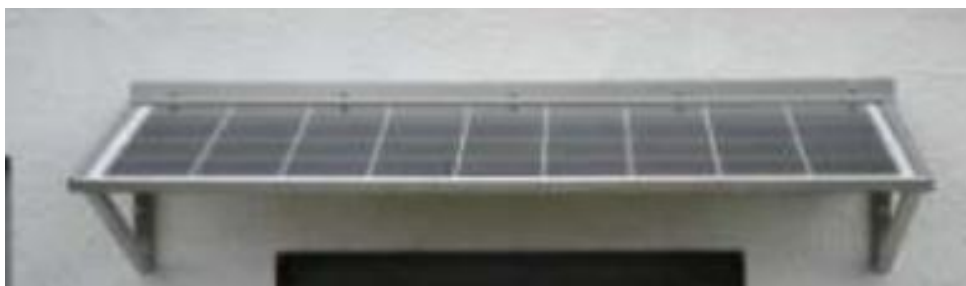
Figura 15 - Instalação em Toldo.
