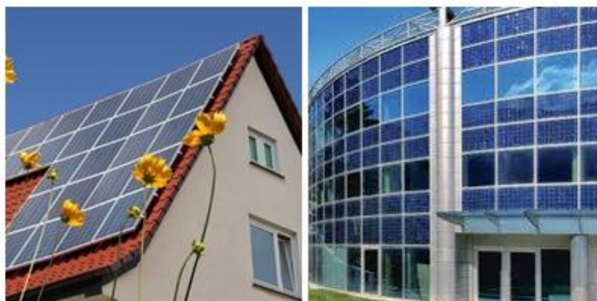
Figura 14 - Instalação em Telhado e Fachada
