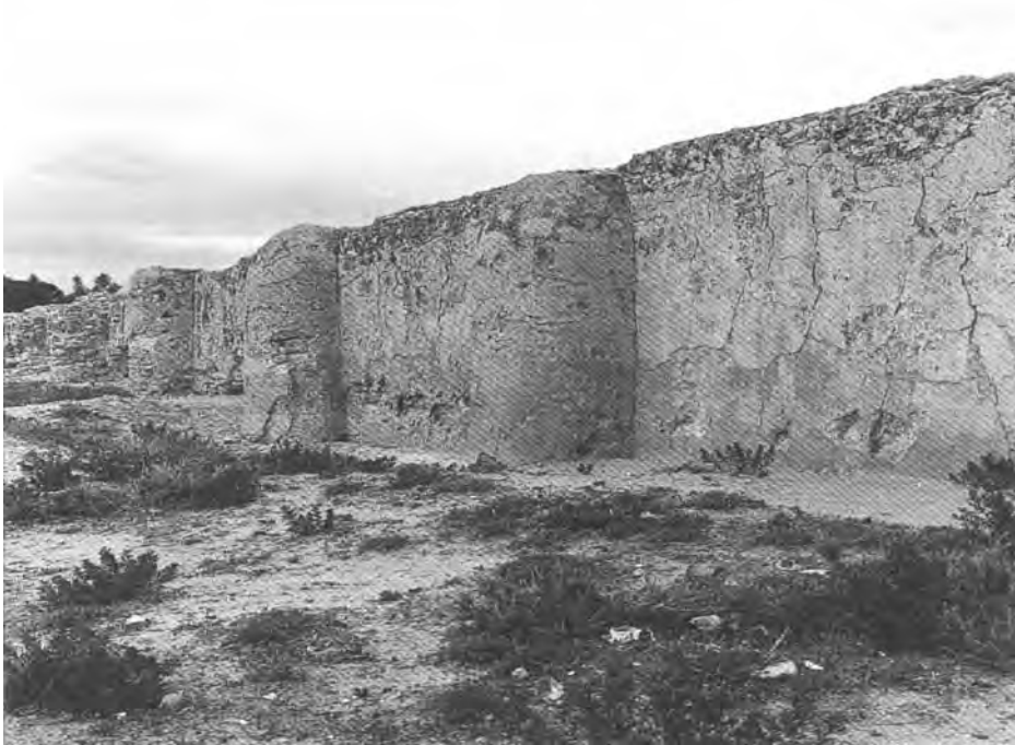
FIGURA 10.5 O grande tanque de Rakāda, nas proximidades de Kayrawān; os enormes contrafortes quebravam as ondas provocadas pelo vento. [Fonte: Instituto Nacional de Arqueologia e Arte, Túnis.]
