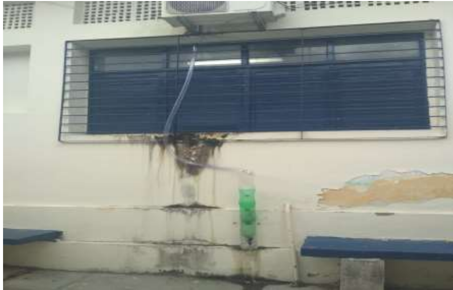
Figura 8. Reaproveitamento da água do ar condicionado.
