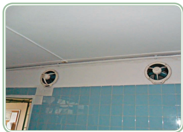
Figura 2.3: Exaustores do laboratório de análise sensorial.
