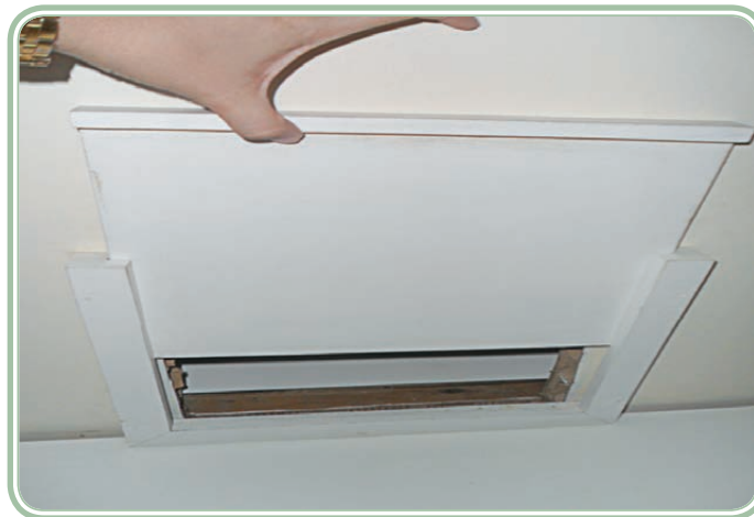
Figura 2.14: Aberturas na cabine para passagem da amostra.
