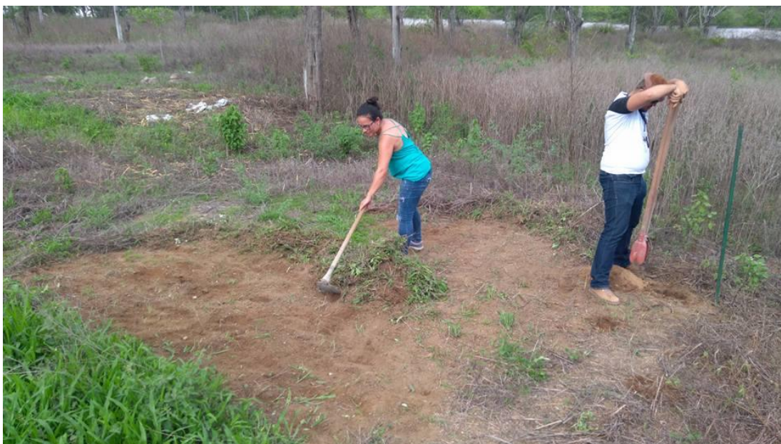
Figura 8: Capinação e nivelamento do terreno
