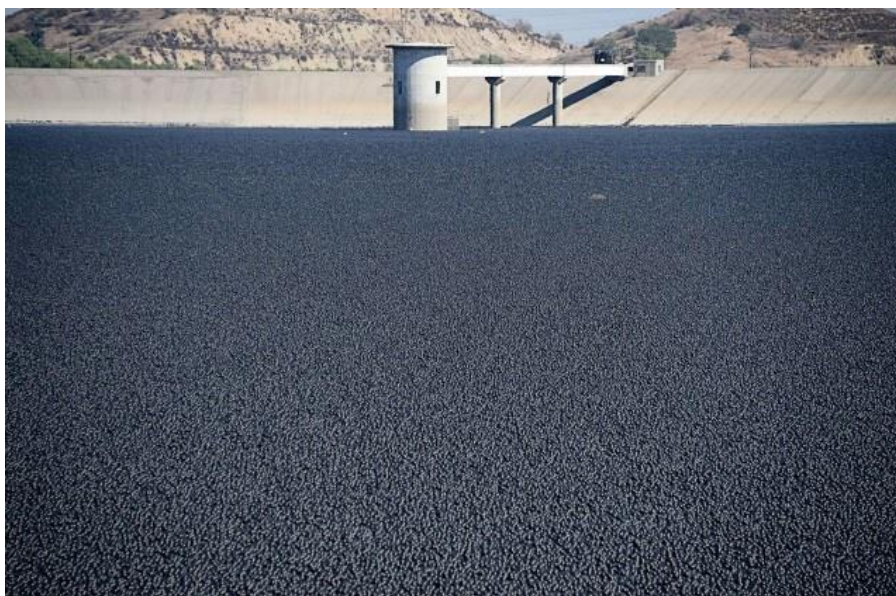
Figura 7: Reservatório coberto pelas bolinhas
